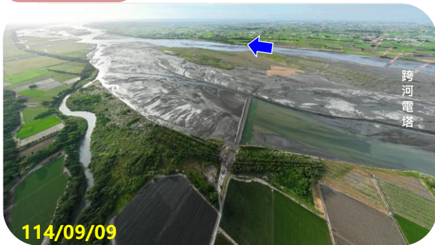
第三區 跨河電塔 下游
