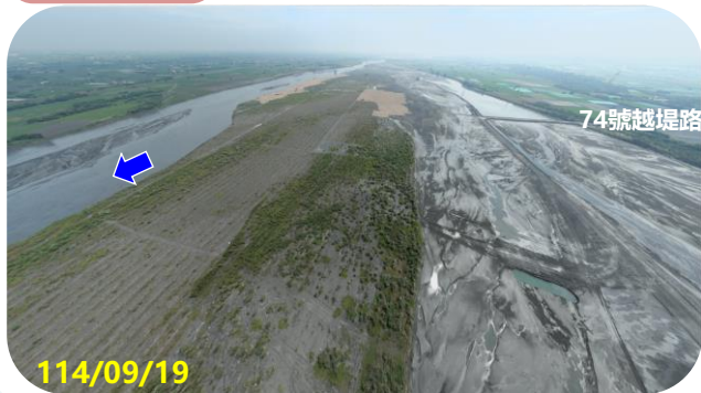
第三區 跨河電塔 下游
