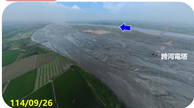
第三區 跨河電塔 下游
