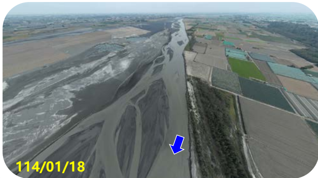
第三區 跨河電塔 下游
