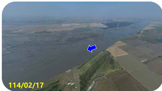
第三區 跨河電塔 上下游
