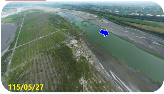
第三區 跨河電塔 下游
