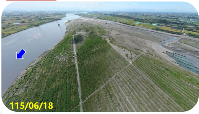
第三區 跨河電塔 下游
