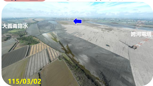
第三區 跨河電塔 下游
