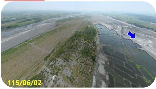
第三區 跨河電塔 下游
