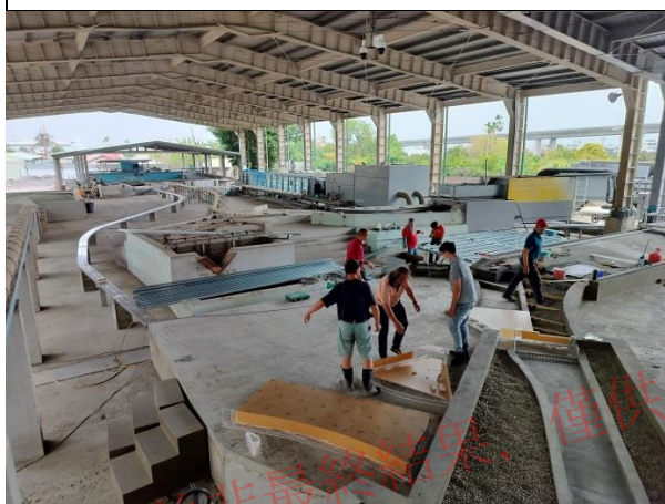
隧道底部支撐架完成
