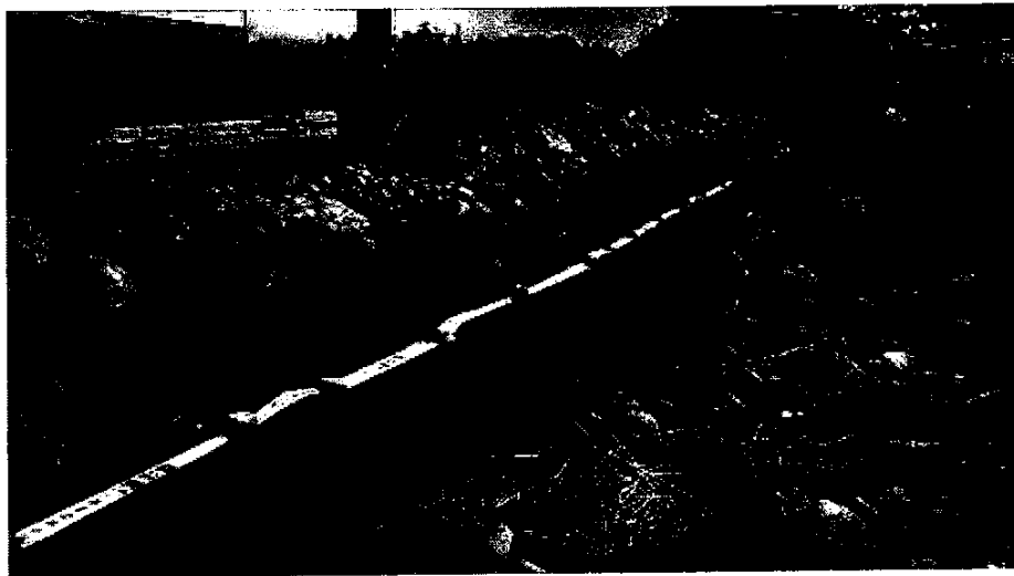
圖2-1 既有管線為以現地材料覆土淺埋方式施作
