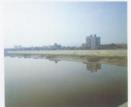
中原堤防施工前
