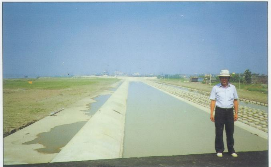
疏洪道入口固定堰
