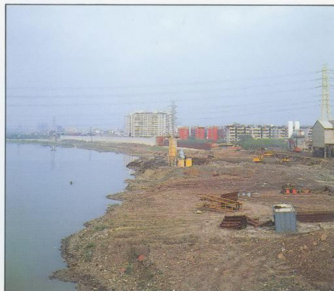
中原堤防施工
