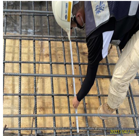
施工中加強隨機尺寸確認
