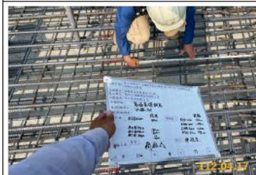
112.04.17 1K+888-905 箱涵基礎鋼筋查驗 副筋④#5@30cm、1.2m-5支
