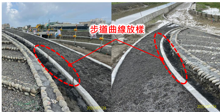
預先放樣水線串聯步道曲線後鋪排
