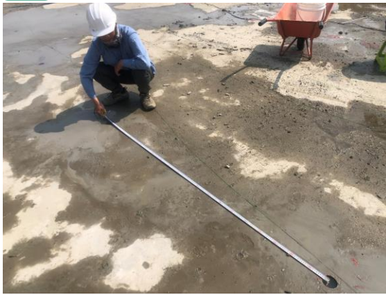
■ 基礎洩水孔間距量測
