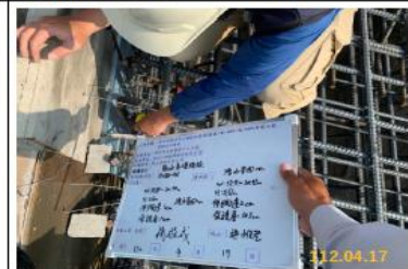
112.04.17 1K+888-905 箱涵基礎鋼筋查驗 保護層 10.1cm
