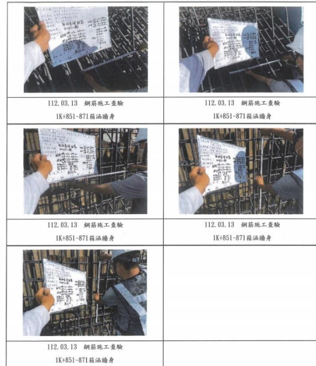
鋼筋施工查驗照片
