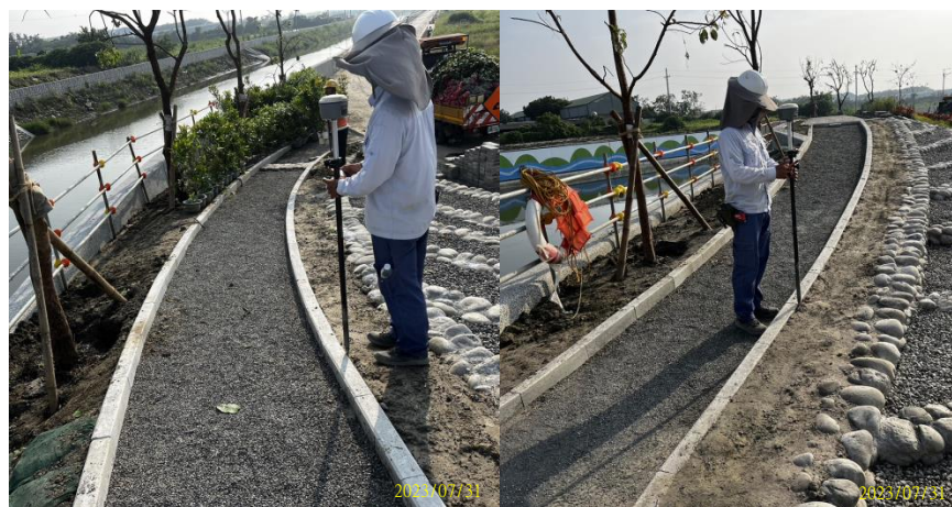
施工後運用RTK再次確認曲線線形
