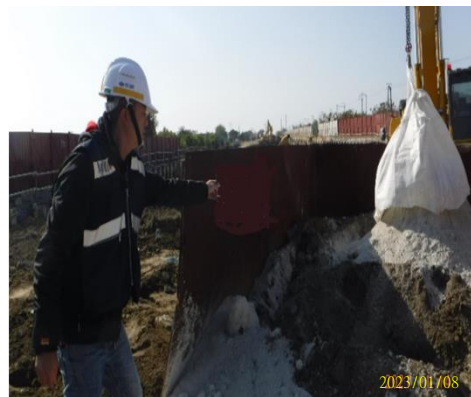
1m 3 爐渣加0.3T地改劑均勻拌合
