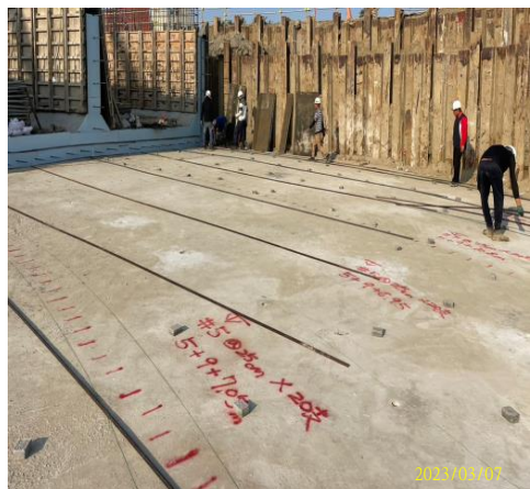
施工前放樣·間距及位置分配確認
