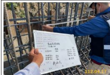
112.04.17 1K+888-905 箱涵基礎鋼筋查驗 牆身預留筋④#8@20cm、1m-6支
