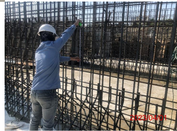
■ 鋼筋間距量測
