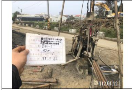
BH-1 鑽探工作施工中
