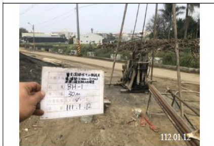
BH-1 鑽探工作施工前
