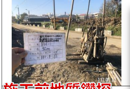
BH-1 鑽探工作施工中
