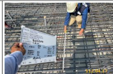
112.04.17 1K+888-905 箱涵基礎鋼筋查驗 上層主筋⑦#8@20cm、1m-6支
