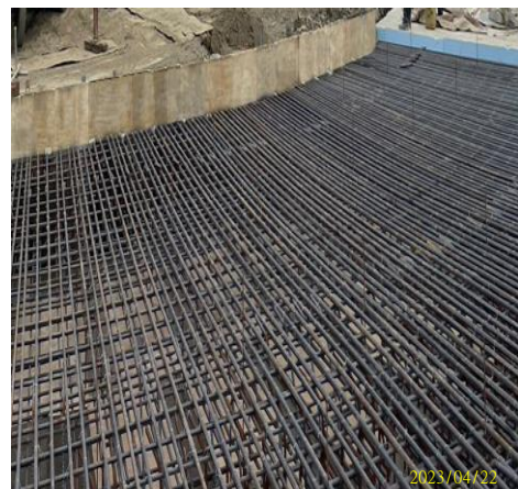
漸變段鋼筋綁紮完成面
