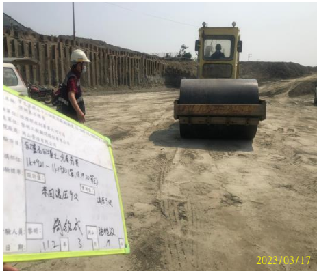
分層滾壓夯實
