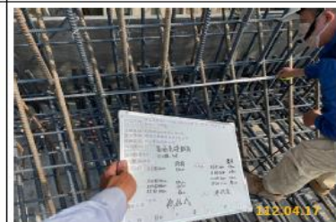
112.04.17 1K+888-905 箱涵基礎鋼筋查驗 牆身預留筋③#8@20cm、1m-6支
