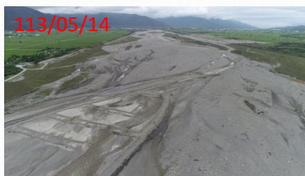
卑南溪於萬安溪匯流口(斷81) 上游之現況斷流照片
