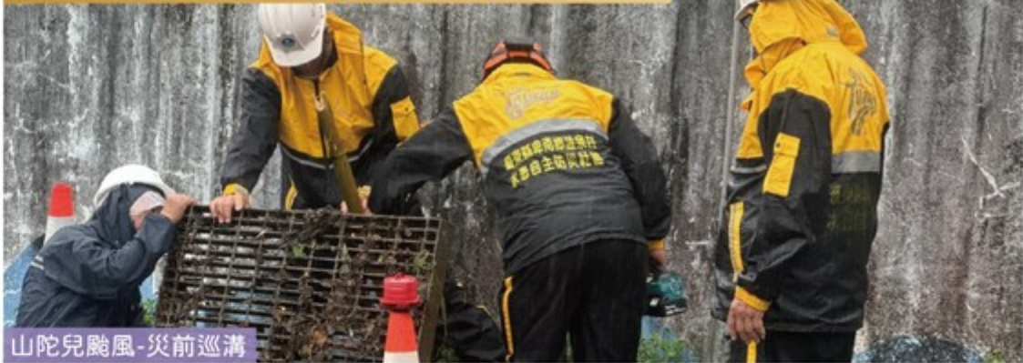
山陀兒颱風-災前巡溝
