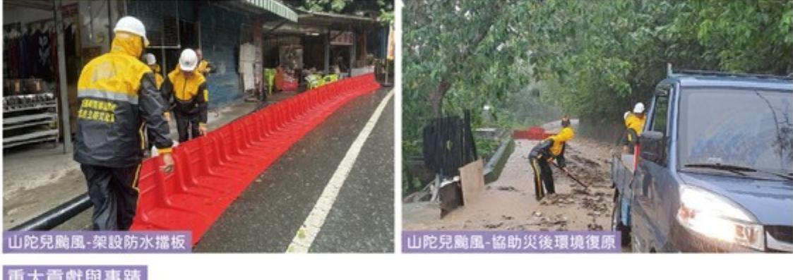
山陀兒颱風-架設防水擋板
