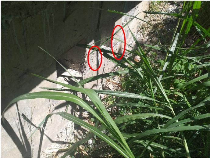
1. 本工程於西南方之道路上配置四組動物通道，原先通道底部與地面的高低差距過大，其中三組通道已改善，第四組位於最西南方)高差超過20公分。通道口處皆有有觀察到長短不一之尖銳之鐵釘突出，恐造成動物受傷或難以利用。
