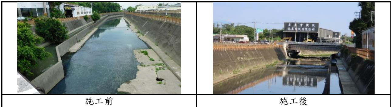
圖 4-25 「嘉義市通港橋改建工程」施工前施工後環境對照
