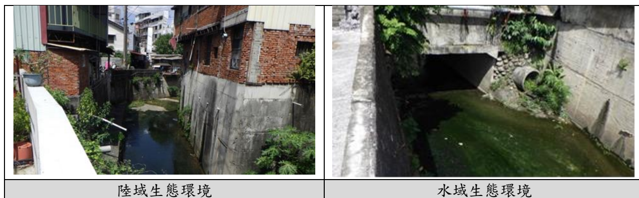
圖 3-15 「北排水 10 號無名橋(6K+209)改建工程」環境照
