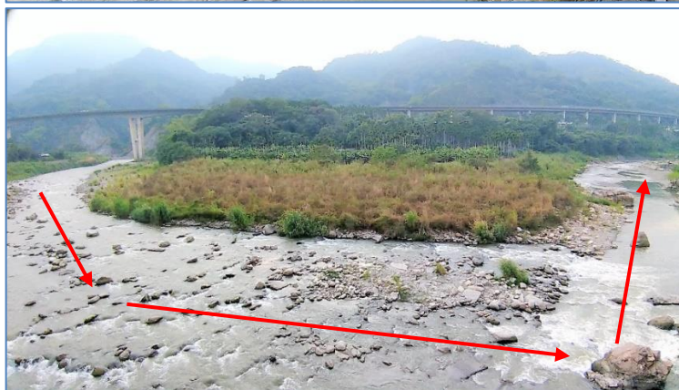
➤ 圖 20. 左岸之嚴重淤積不僅需清除，且力道需足夠，流路更需隨之調整，107-11-9。
