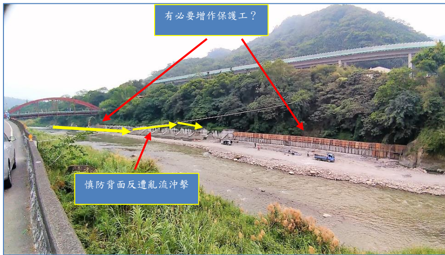
➤ 圖 12. 在既有工事之上下游進一步施作保護工，慎防反減低通洪斷面，背面遭沖擊；另施作護坦工，界面又出現弱點，讓問題更無解，107-11-9。
