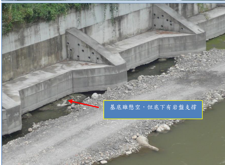
➤ 圖 17. 上圖近照，不僅工事懸空，基底還有岩盤支撐，顯示當初工事非必要，107-11-9。
