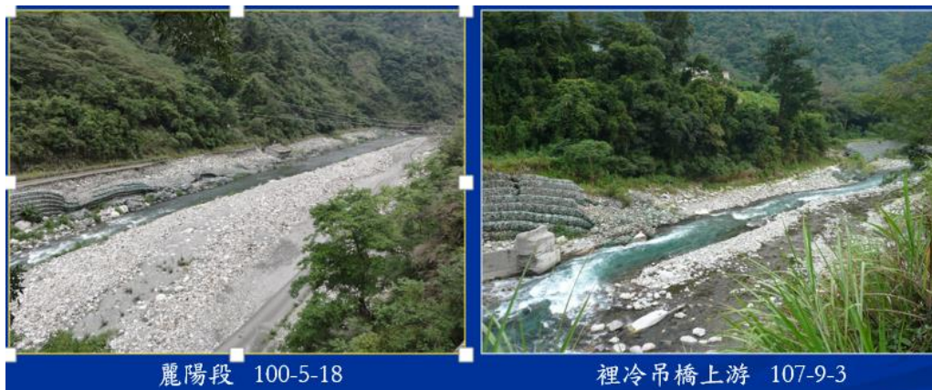
➤ 圖 1. 九二一地震後大甲溪谷關下游之左岸幾皆全面築起石籠護岸，以作為疏浚之通道，但日後卻幾皆被洪流沖毀。
