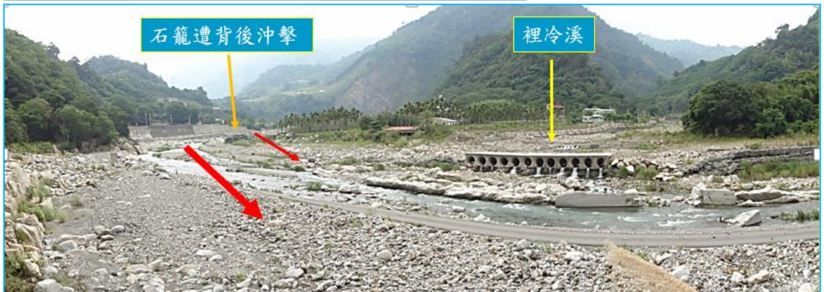
➤ 圖 5. 豪大雨時裡冷溪同可致水患。若硬要施作護堤，可於此匯流處施作開口堤，讓該地同擔負起滯洪之功能，100-5-18。
