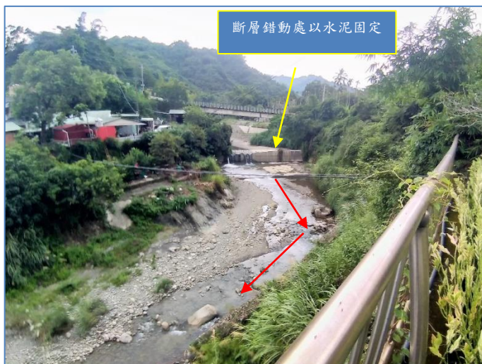
➤ 圖 6. 斷面一：竹村橋下游，由下往上望。問題主出在：九二一地震車籠埔斷層之錯動，河段蜿蜒出現之沖淤，系列固床工出現上淤下淘。111-8-19。
