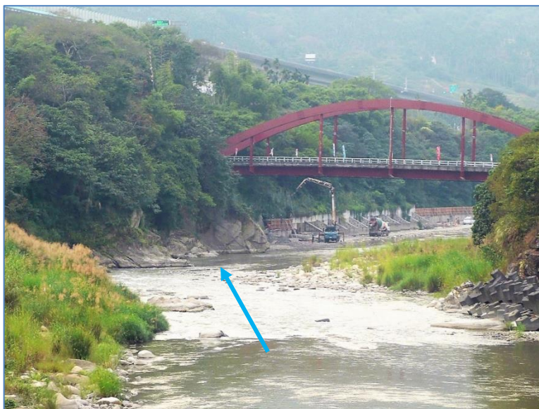
➤ 圖 12. 在既有工事之上下游進一步施作保護工，慎防反減低通洪斷面，背面遭沖擊；另施作護坦工，界面又出現弱點，讓問題更無解，107-11-9。
