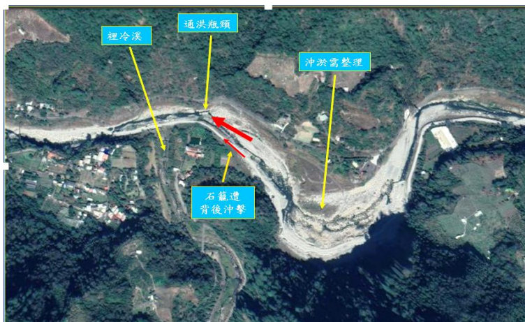
➤ 圖 2. 有必要在上游急轉處整理河道，移右岸之淤砂填補左岸。而後適度疏浚該河段，並將左岸拓寬，以增加通洪斷面，圖像取自 Google earth。
