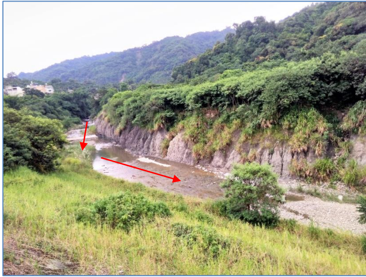
➤ 圖 8. 斷面二至三：右岸雖遭沖擊，但整河床施設系列固床工，將砂石固定，致整體呈現淤積狀，111-8-19。
