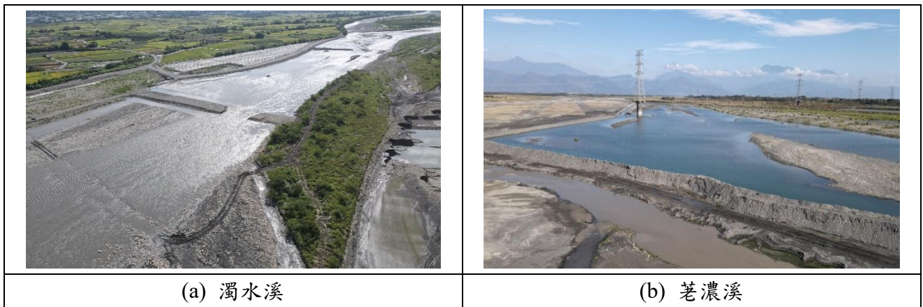
圖 4-3 簡易土堤類型之河槽補注設施
