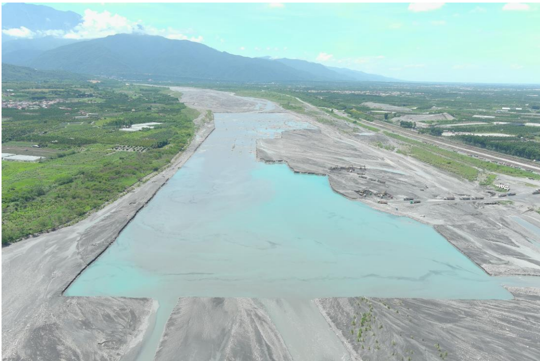
(b) 補注設施完工
