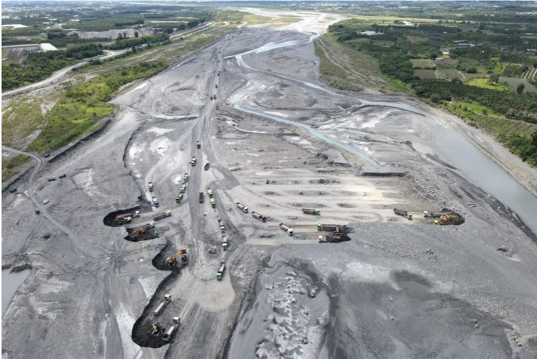
(a) 補注設施施工中
