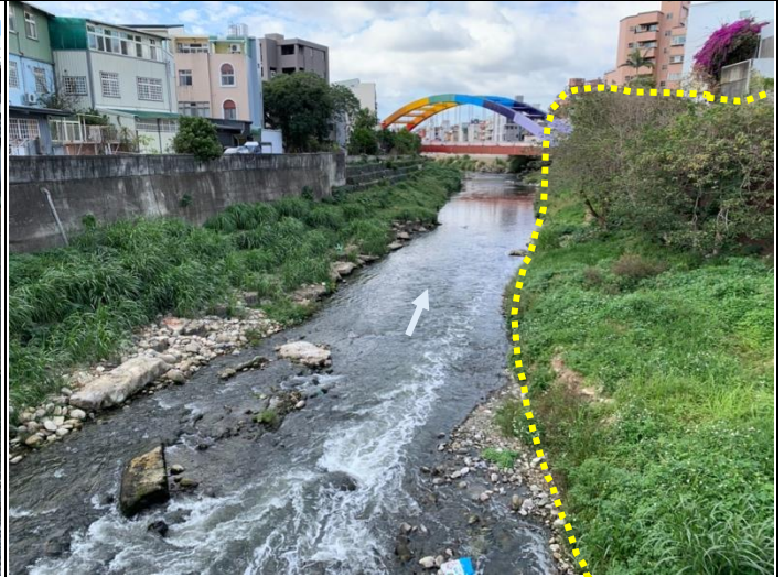
說明：印順橋上游左右岸均有箱籠結構，往上游處左岸漸變為垂直混凝土護岸，低水護岸部分已有濱溪植被，以巴拉草、象草、蓖麻等外來物種為主。黃線範圍為建議保留區域 日期：2022.01.19
