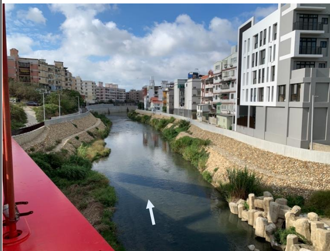
說明：印順橋以下溪段為部分漿砌石護岸，往下游漸變為垂直混凝土護岸，兩岸有小部分漿砌石護岸下緣已有象草或巴拉草族群 日期：2022.01.19
