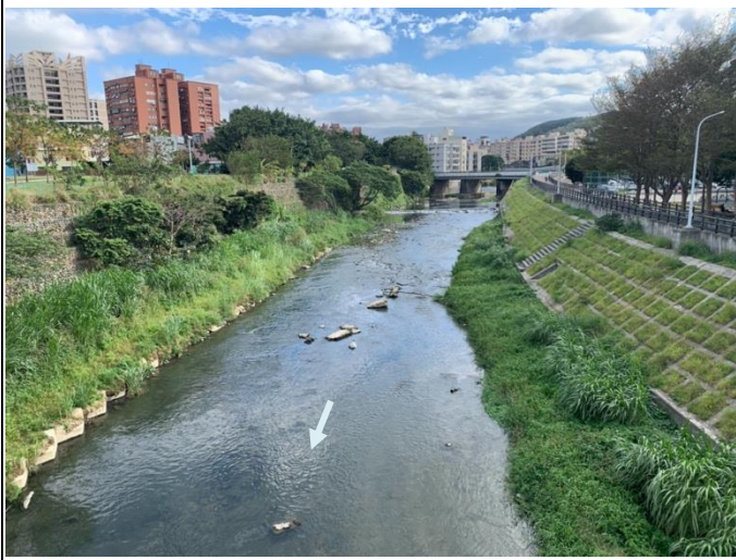
說明：中華路至中山路間右岸為箱籠結構，左岸為混凝土格框護岸。右岸護岸植被覆蓋狀況佳，左岸則為凸岸於低水護岸外淤積處有植被建立 日期：2022.01.19
