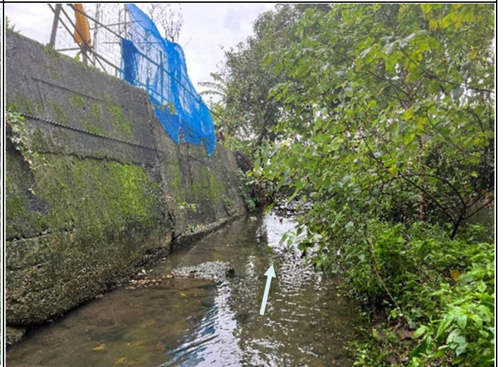
說明：南門溪段上游處部分溪段樹冠覆蓋度高 日期：2022.02.21
