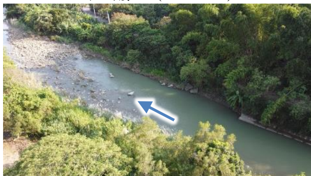
下游右側水岸護坡及土坡環境 (110.10.05)
