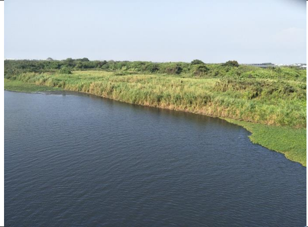
工程左岸廊道
