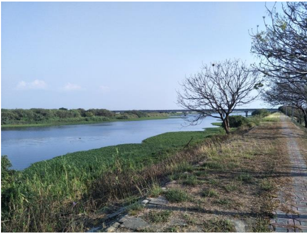
右岸堤防現況
