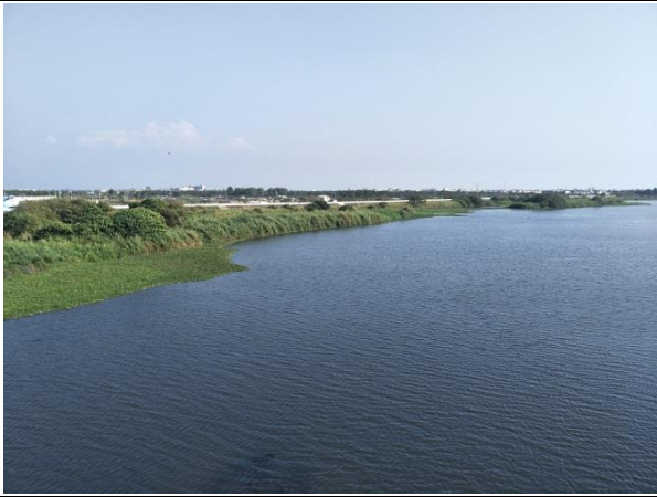
工程右岸廊道
