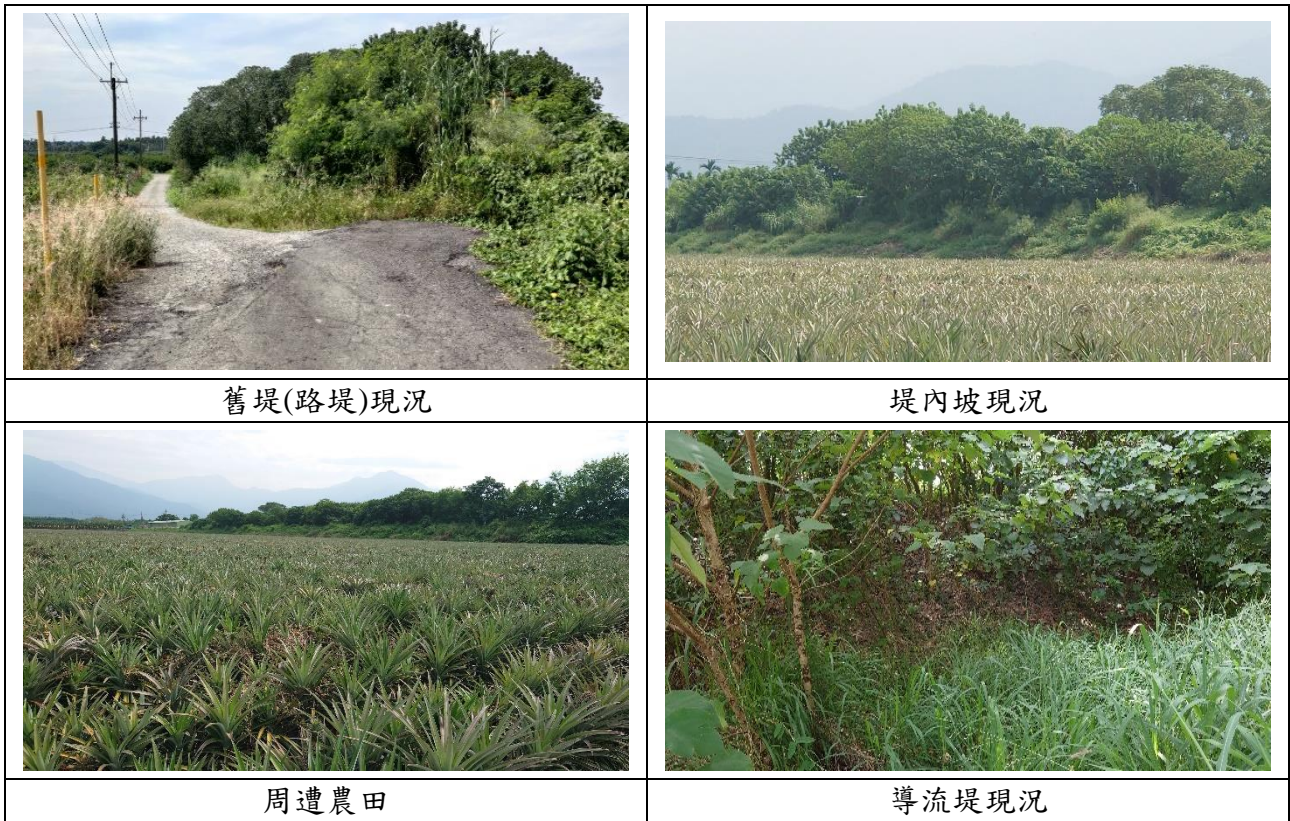
圖 2-1 隘寮溪舊南勢橫堤段(含導流堤)改善工程環境現況照
