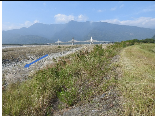
工區段-水流左岸之堤防。(2019.11.14)
