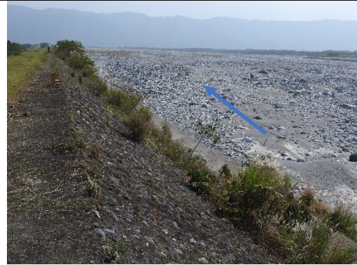
工區區段-水流左岸之堤防。(2019.11.14)
