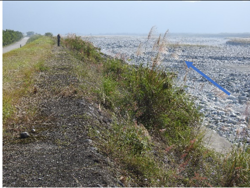
工區段-水流左岸之堤防。(2019.11.14)
