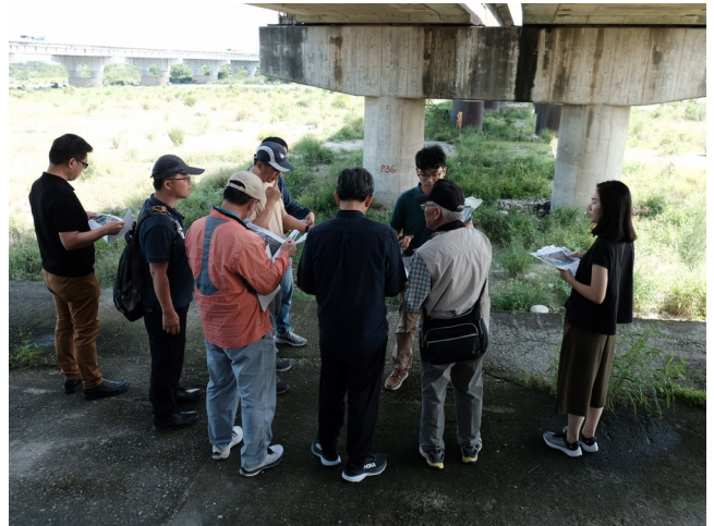
與會者於海線鐵路橋橋墩旁進行討論
