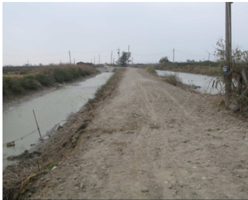
事故發生位置之道路、排水溝關係位置
