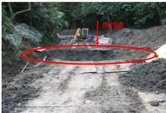
固床工基礎開挖處
