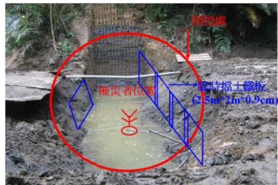
固床工基礎開挖處及罹災者位置
