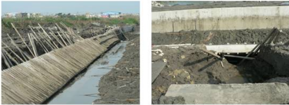
堤岸模板拆除現場狀況
