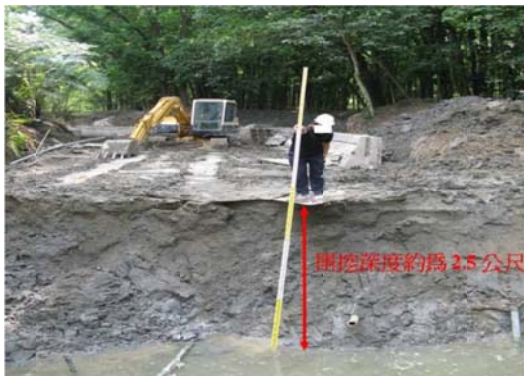
基礎開挖深度約 2.5 公尺
