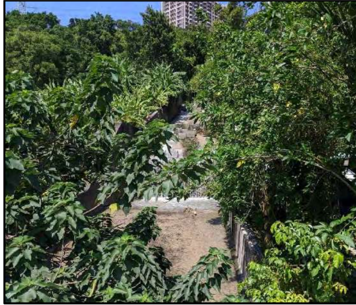
圖7 埔頂排水渠道現況
