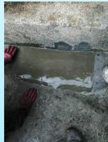
因淨化槽尚未運作，連接管線堵塞現場處理情形。
