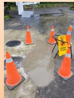
因車輛輾壓，造成淨化槽表面破損，打除修復情形。
