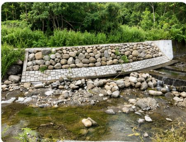
護岸及固床工
