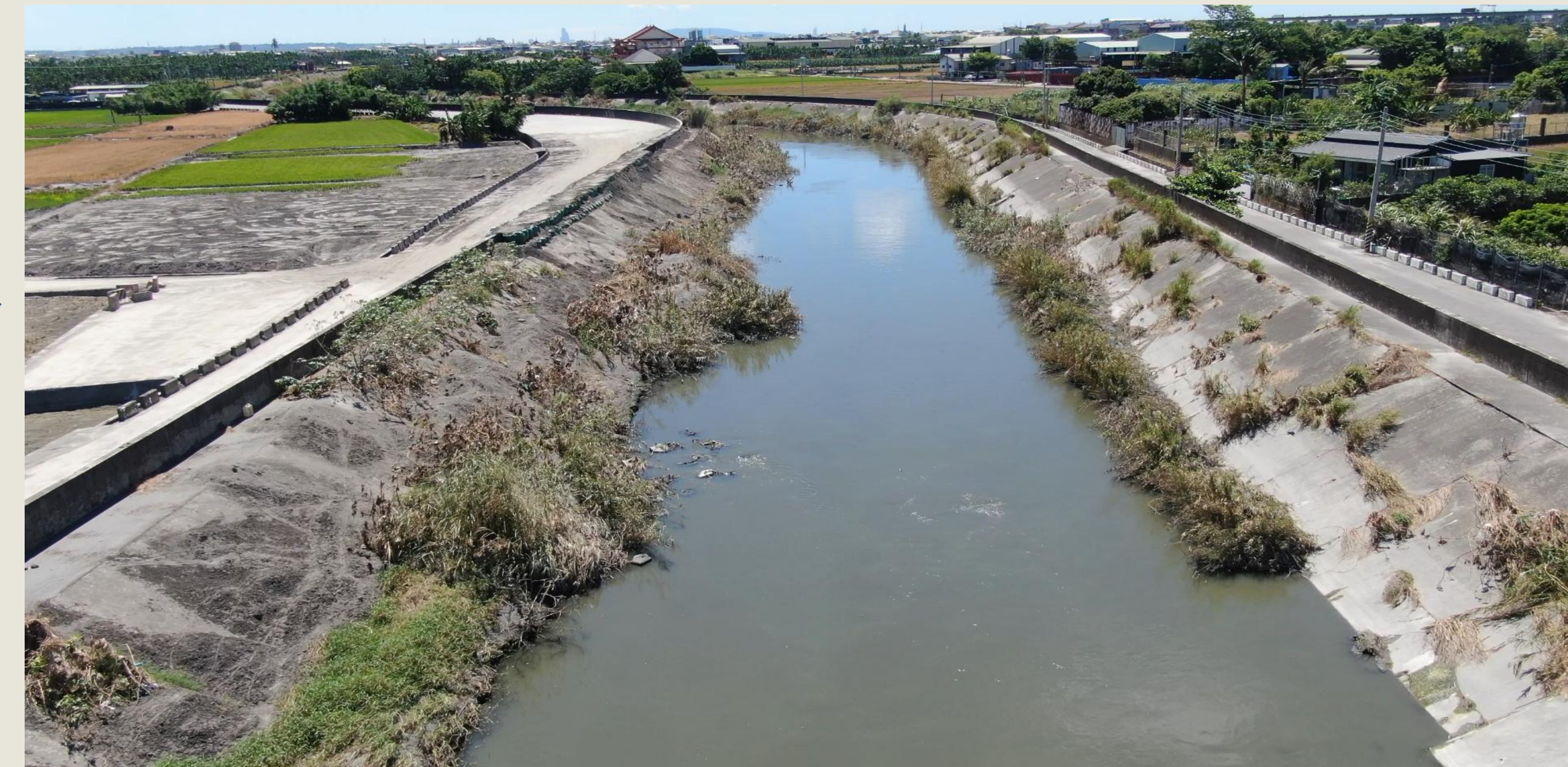
115年6月26日溢堤搶修修復
