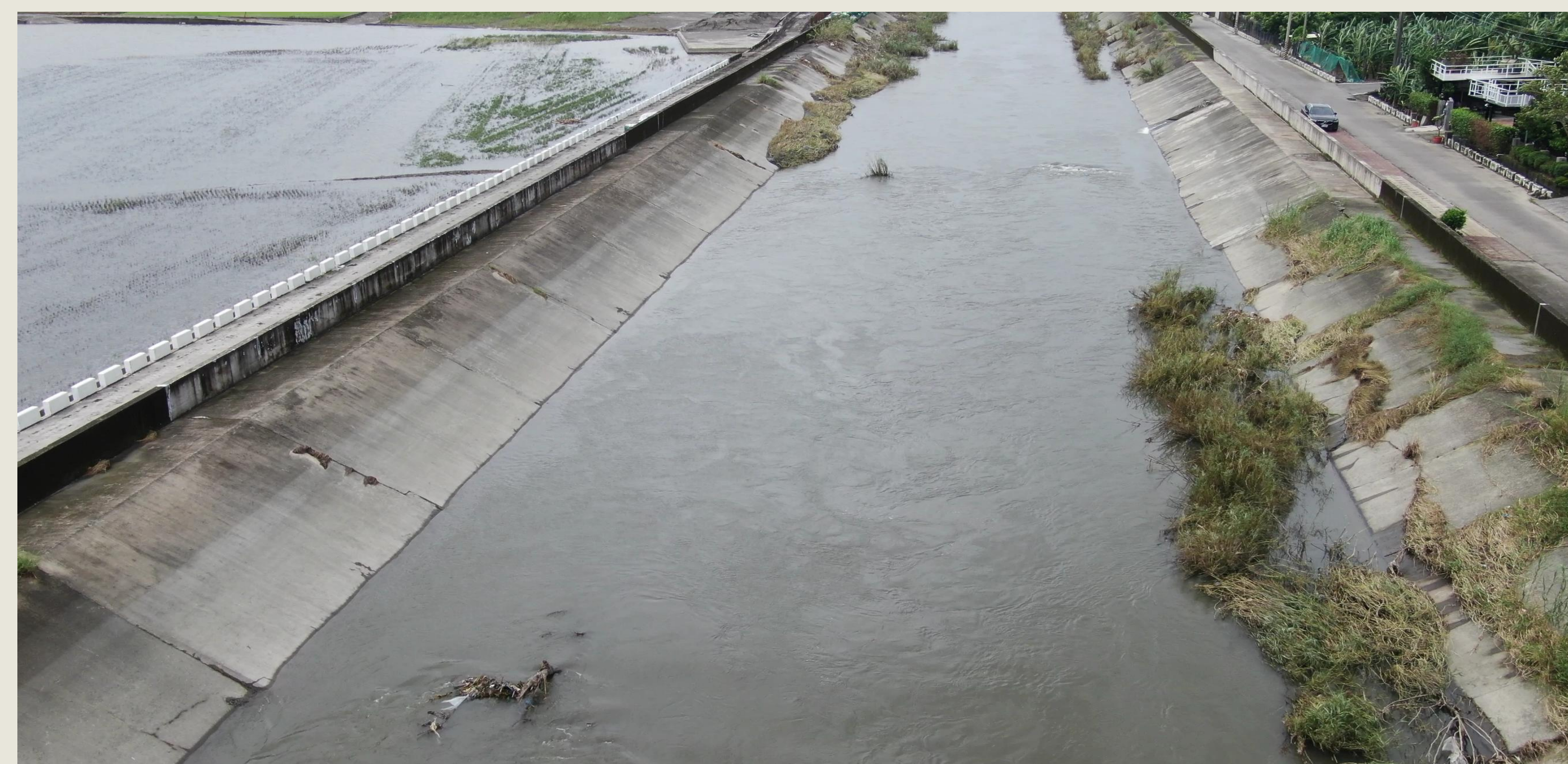
110及113年破壞修復
