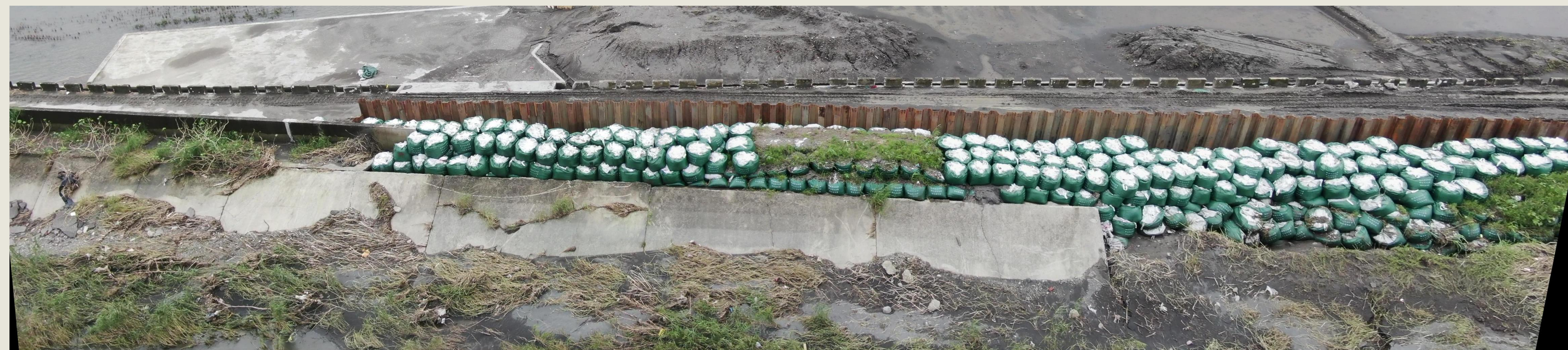
版樁施打現況
