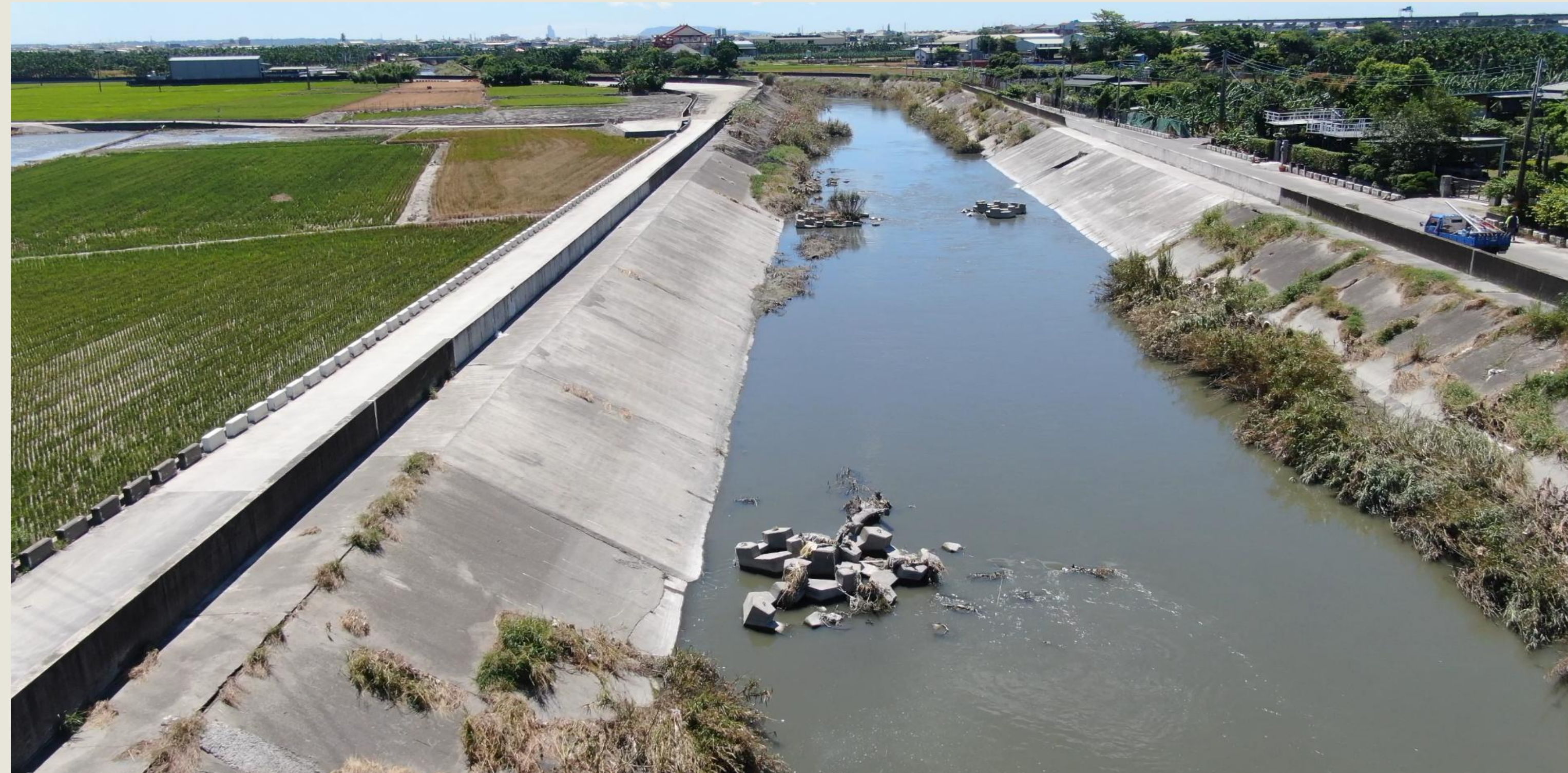
110及113年破壞修復
