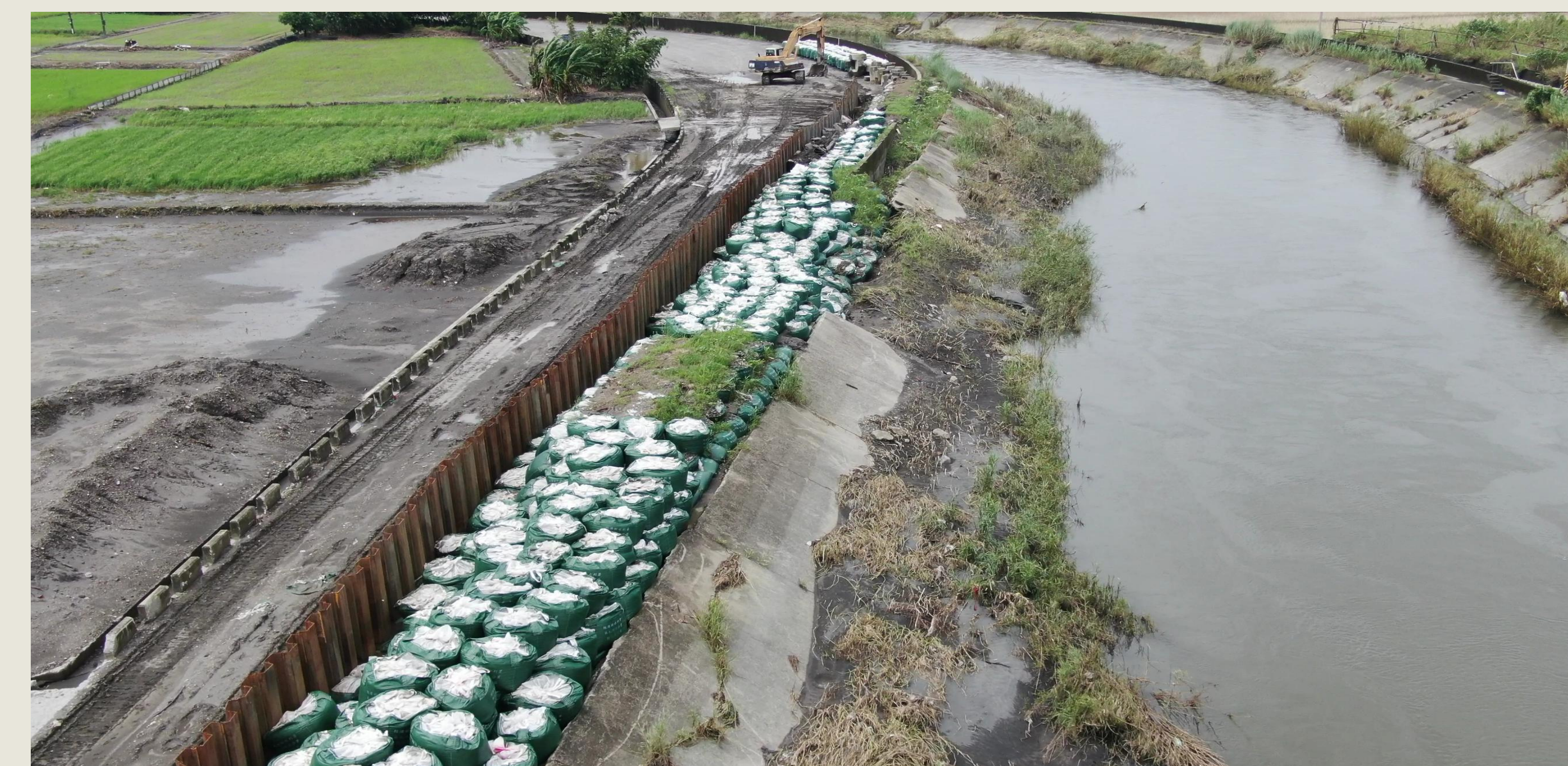
115年8月27日溢堤搶修修復
