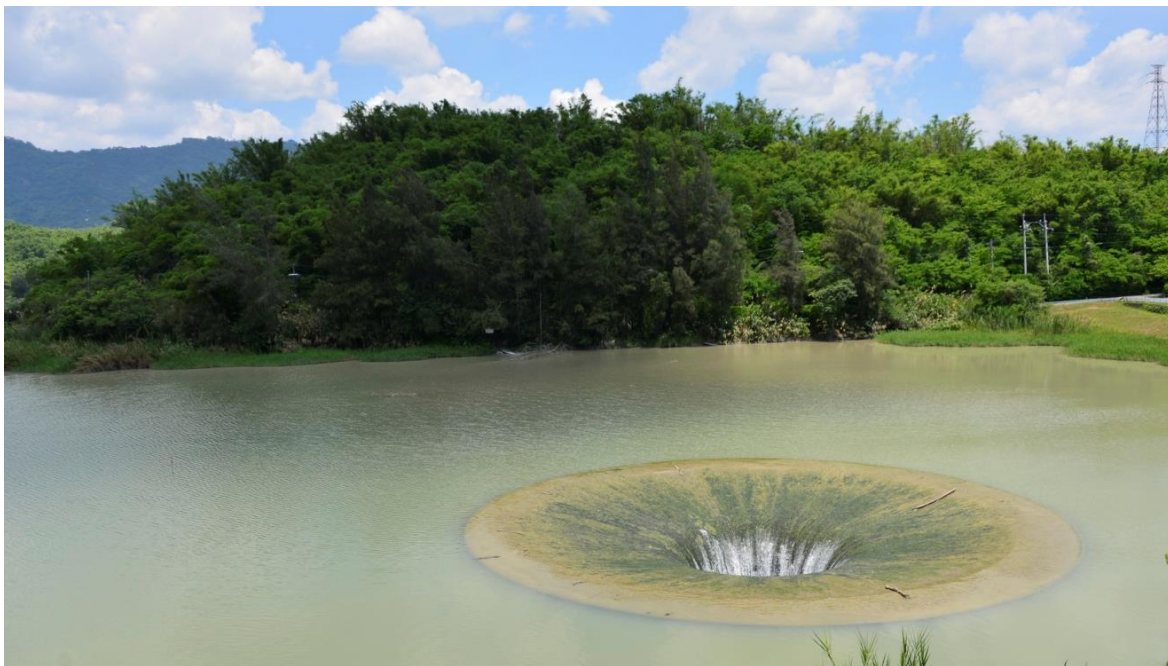
烏山嶺引水隧道西口天井入水口
