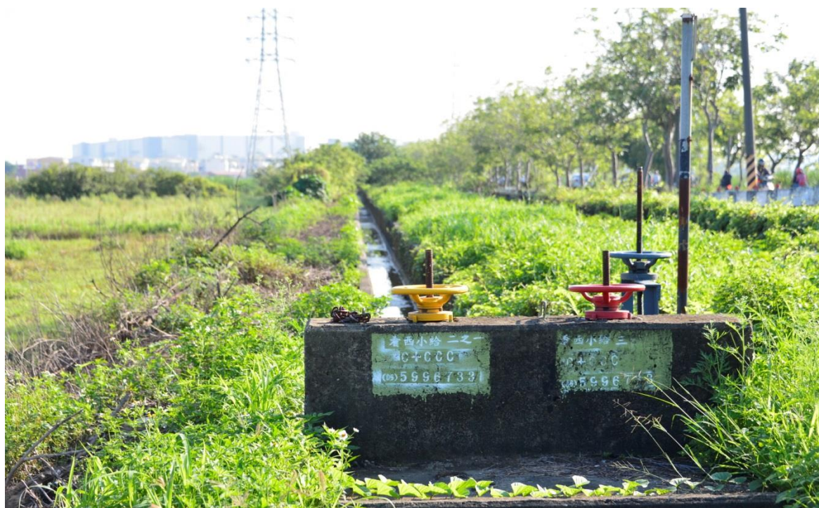
嘉南大圳南幹線支線水門設施
