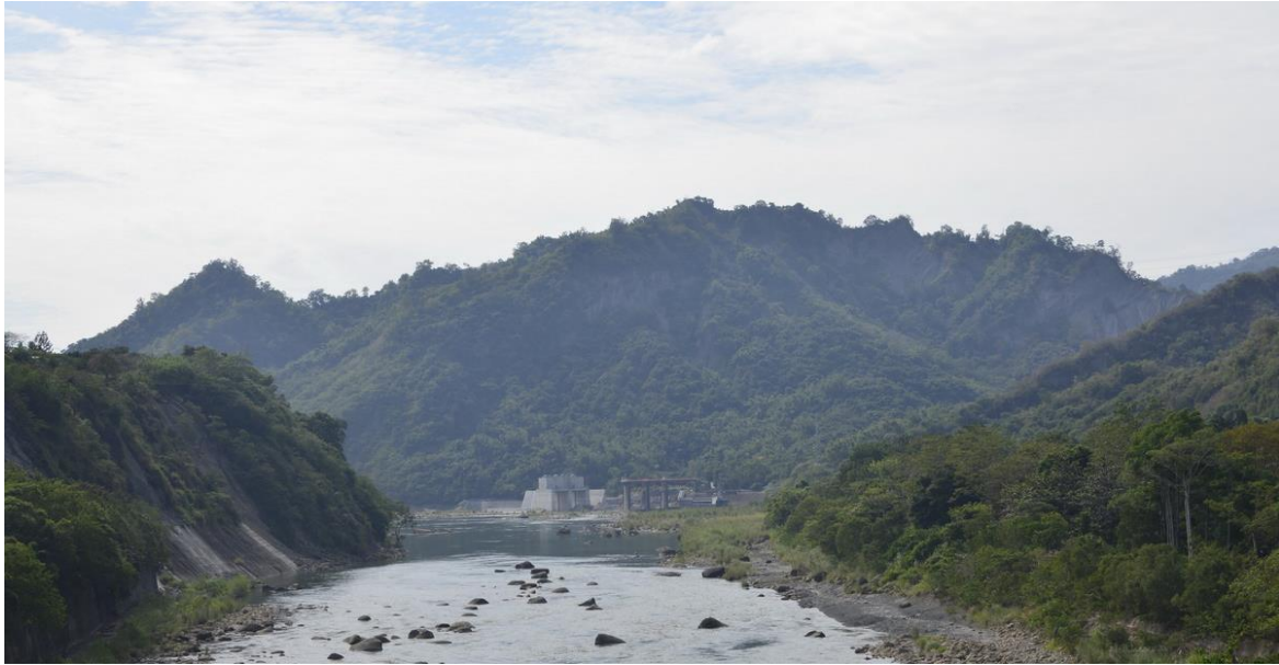
新烏山嶺引水隧道東口攔河堰
