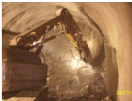
STEP 2. 機械開挖情形
