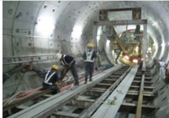
STEP 3. 出渣及鑽掘延伸作業
