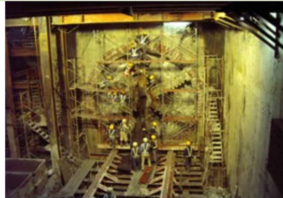
STEP 4. 到達井鏡面及破鏡
