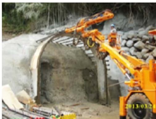
STEP 1. 洞口段管幕先撐保護
