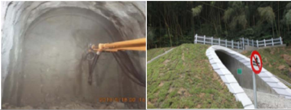
STEP 3. 鋼支保及噴凝土支撐
