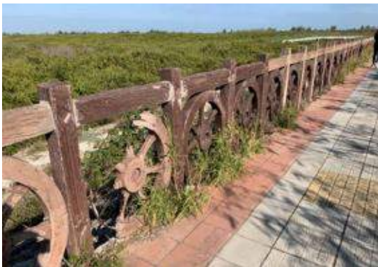
既有牛倫護欄損壞
