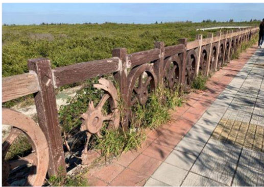
既有牛輪護欄損壞
