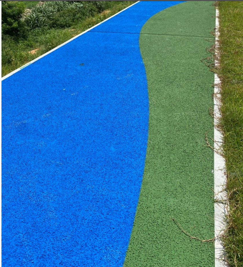
說明 透水混凝土鋪面。
