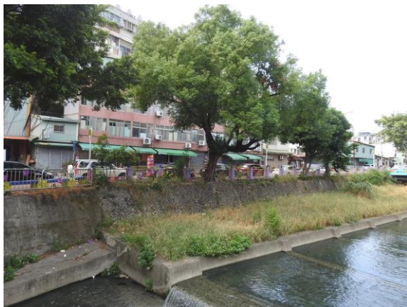
圖 7、現地情況 ( 邊坡、水域及高灘地 )
