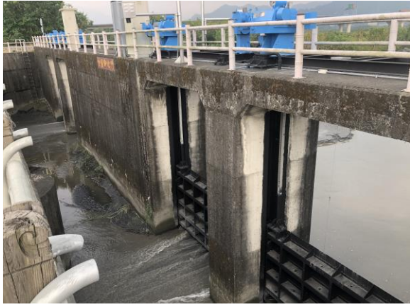
香圓腳進水口閘門
