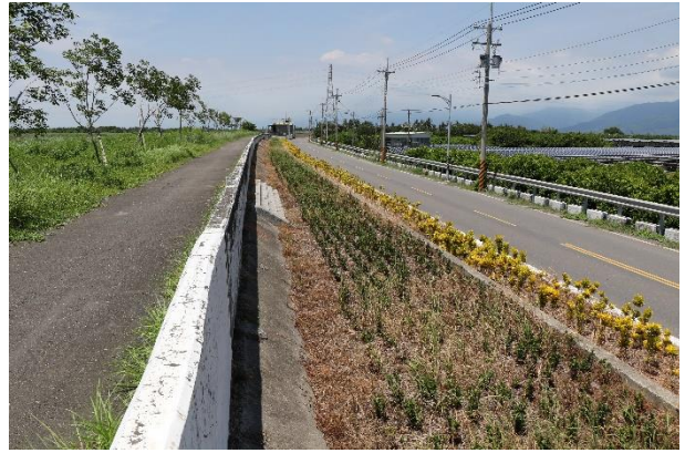
堤防道路旁增設複層花臺照片 2023.07.21
