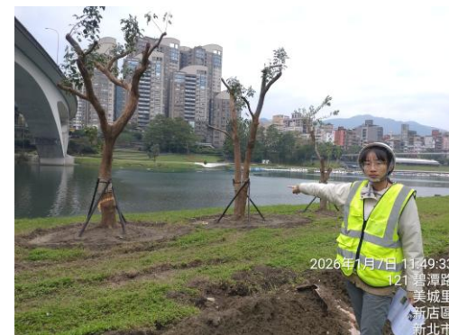
施工中查核生態保育措施
