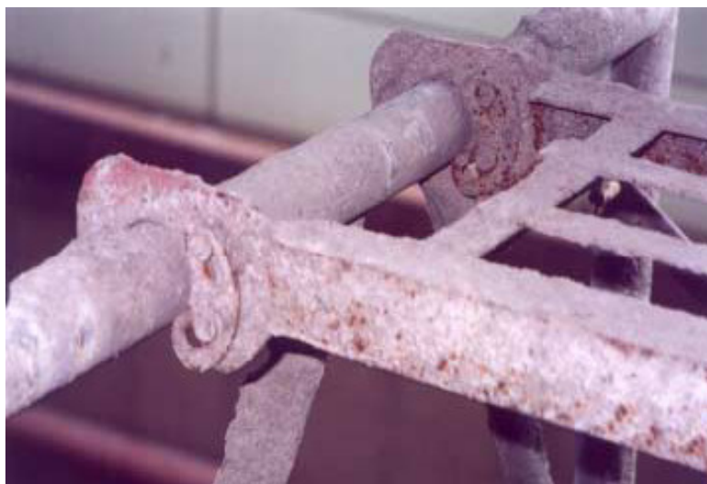
圖 17 工作板橫架扣鎖之裝置生鏽
