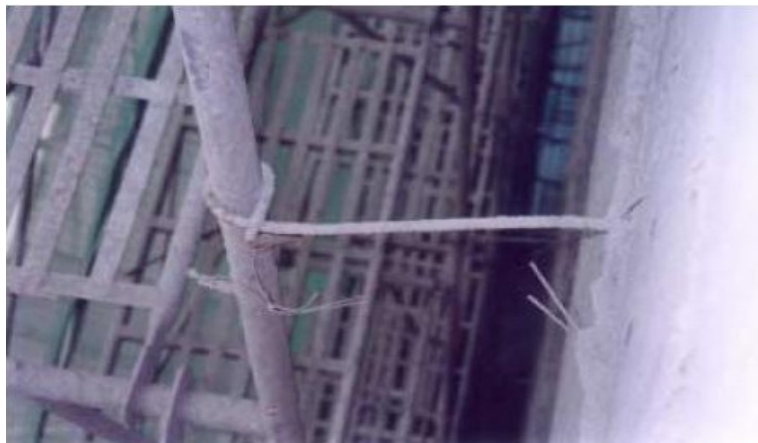
圖 19 壁連座使用三號鋼筋代替
