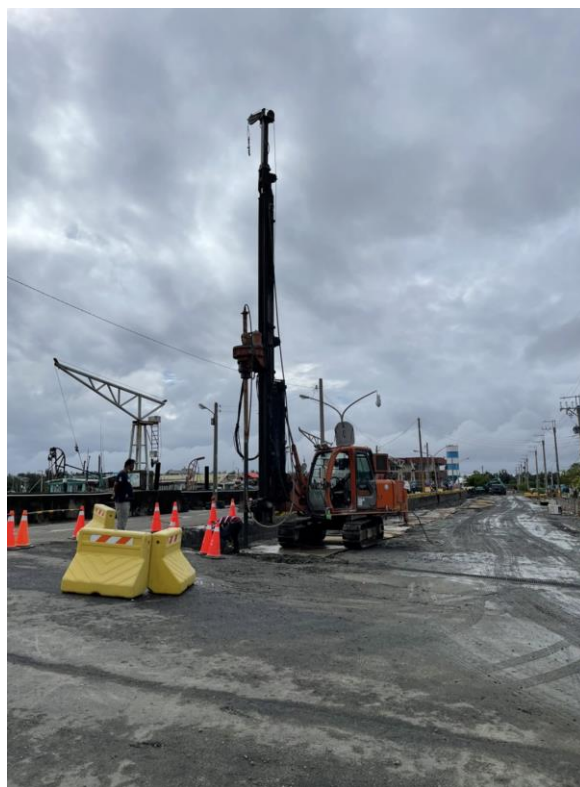
高壓噴射攪拌止水樁施工
