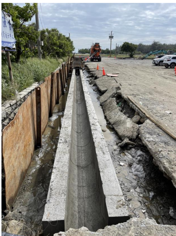
水溝混凝土澆置
