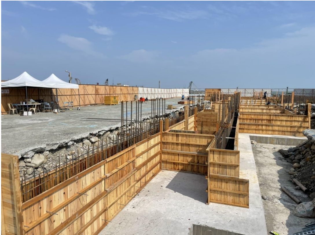
中央景觀臺地梁模板組立
