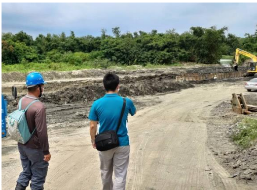
以既有道路設置施工便道(110/07/15)
