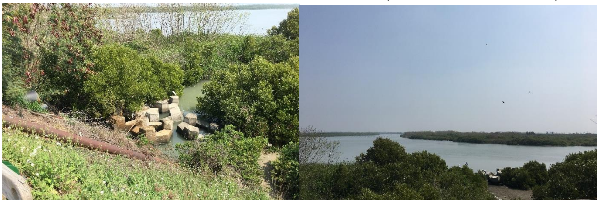
圖 3-1.6 東石鄉海埔堤防混凝土塊加強段 (勘查日期：111/03/03)
