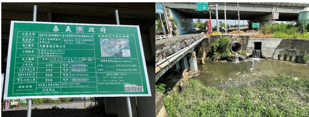
圖 3-2.6 貨物轉運中心聯外排水幹線埋設工程 (照片日期：111/09/08)
