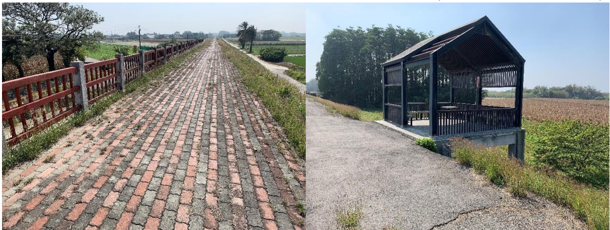
圖 3-4.4 堤頂部分堤段設置壓花鋪面及觀測台 (勘查日期：111/1/26)
