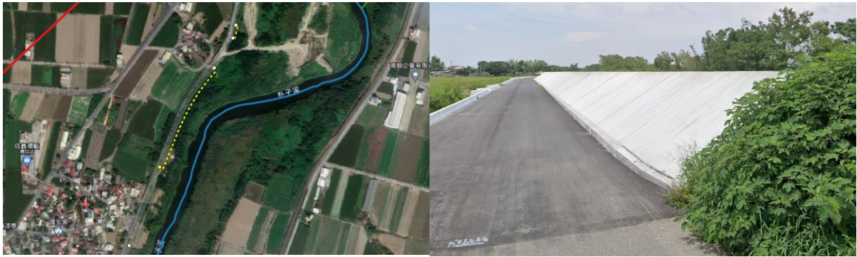
圖 3-3.5 蒜頭堤防-右岸編號 55 勘查點 (長度約 270 公尺)
