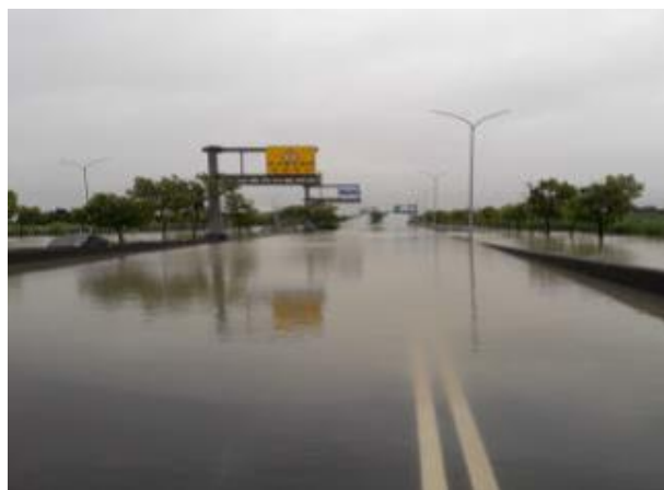
台 18 線-埤麻腳排水右岸
