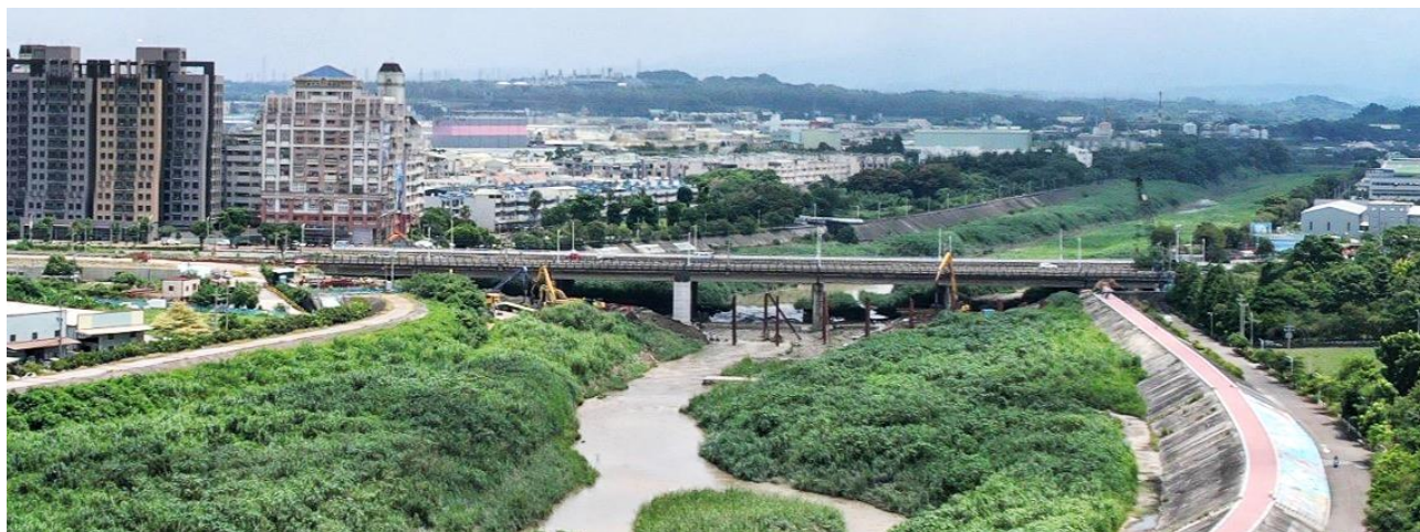
圖 2-1.32 嘉義計畫鐵路高架橋及橋下平面道路工程-牛稠溪工區基樁施作現勘 (勘查日期：111/8/11)
