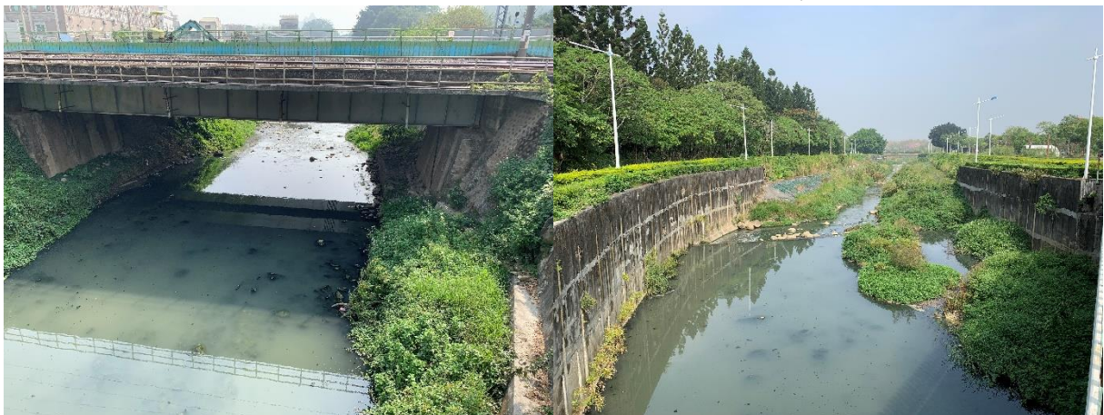
圖 3-4.9 北排水現況勘查 (勘查日期：111/3/16)
