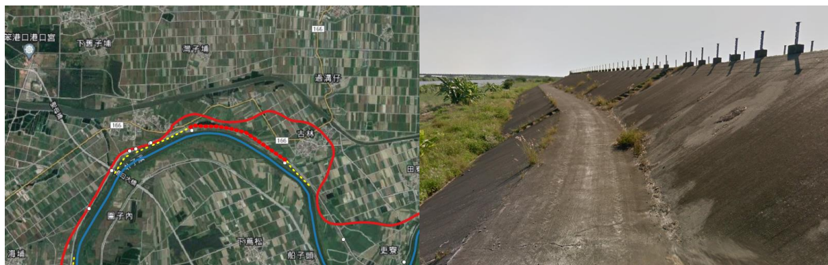
圖 3-3.8 下揖堤防-右岸編號 20 勘查點 (長度約 3,200 公尺)
