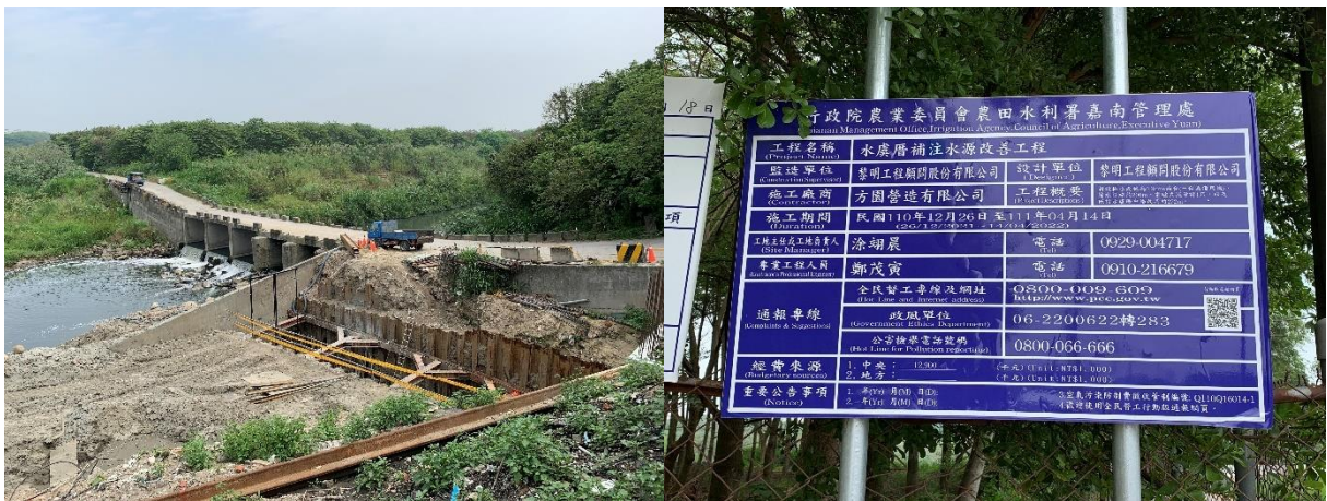
圖 2-1.30 朴子溪無名橋-水虞厝補注水源改善工程現勘 (勘查日期：111/4/7)
