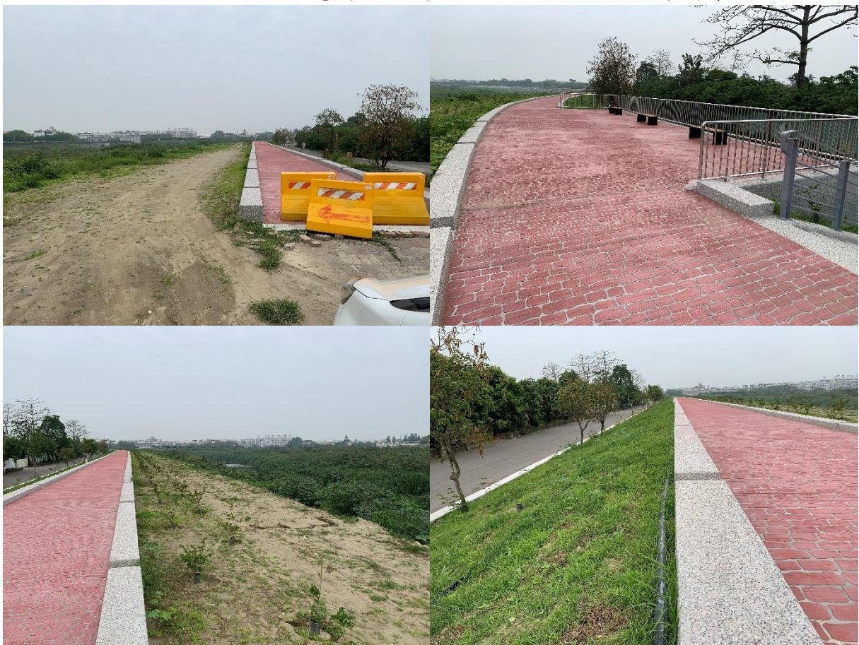
圖 2-3.14 朴子溪老藤堤防維修改善工程現況勘查(勘查日期：111/04/07)
