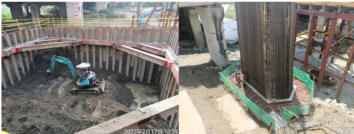
圖 2-1.31 嘉義計畫鐵路高架橋及橋下平面道路工程-牛稠溪工區基樁施作現勘 (照片日期：111/2/17、111/7/8)
