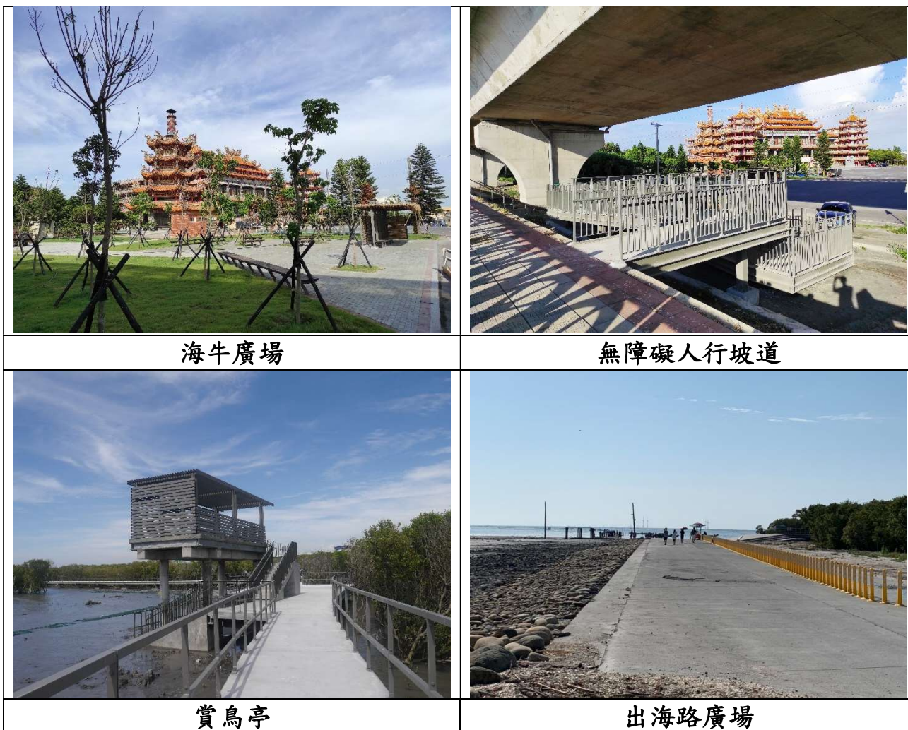
第一期完工照片
