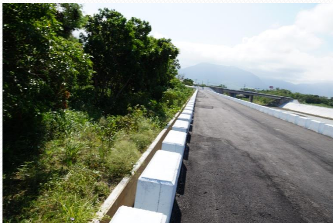
右岸現況照片
