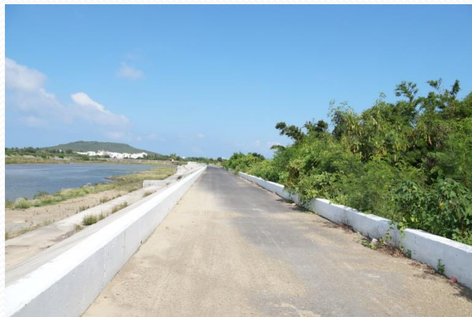
右岸現況照片
