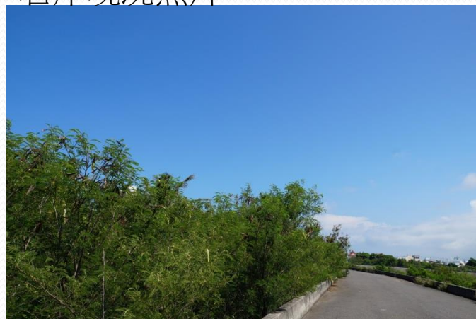
左岸現況照片
