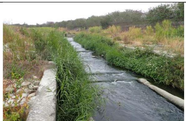
河中固床工營造坡度較大且狹窄處水流較湍急
