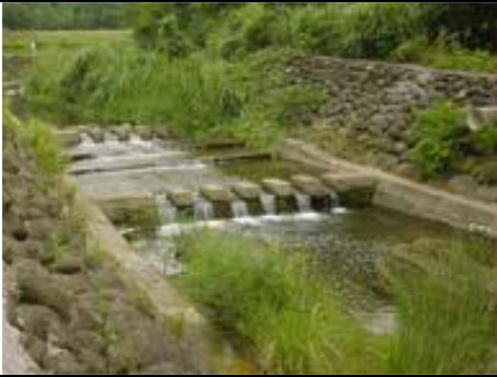
跌水式混凝土基座鑲石固床工範例
