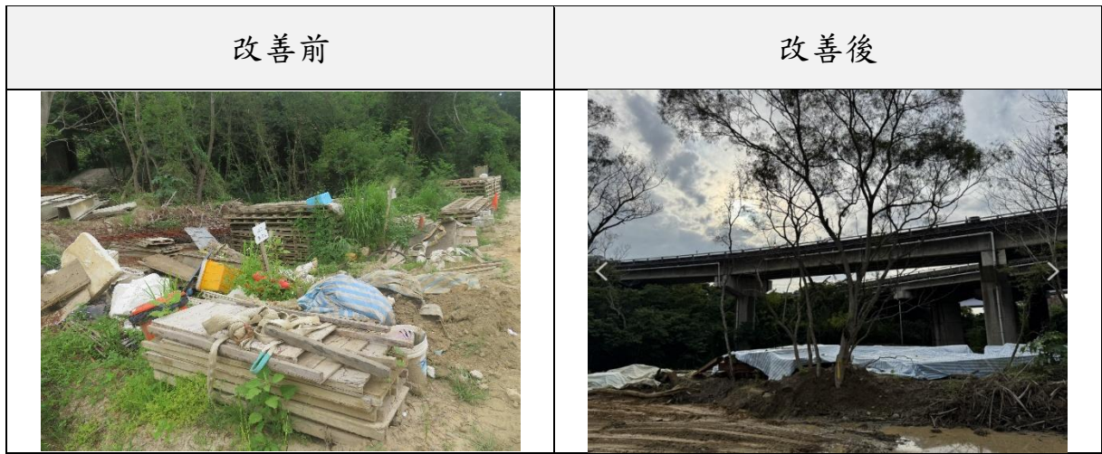
圖 3-36 現場環境改善前後照片
