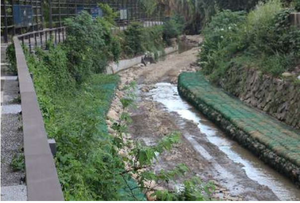
水流於工程便道上從右側水道變道至左側水道 (遠照)
