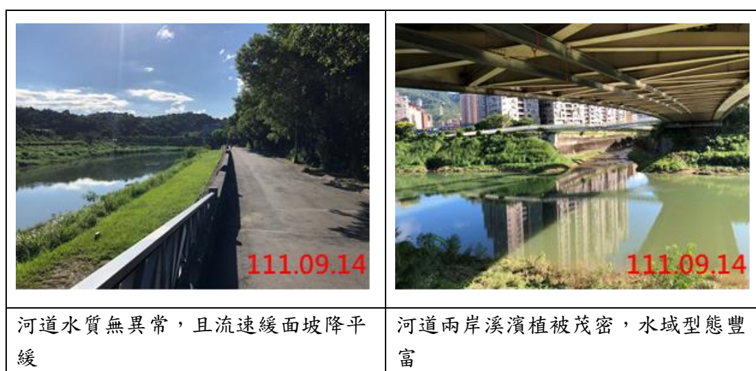
圖 7-13 汐止聯絡道休憩廊道串聯工程生態保育措施執行後現況示意圖
